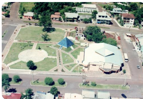
Construção do centro Administrativo Prefeitura
