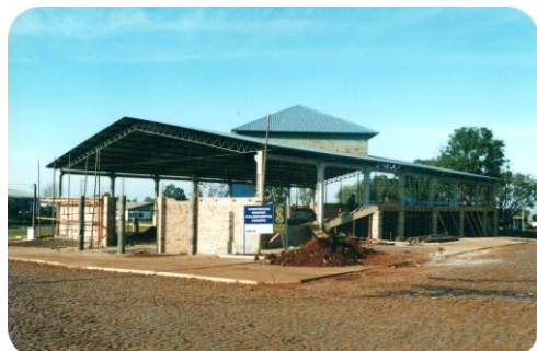
Construção do Ginásio Municipal
